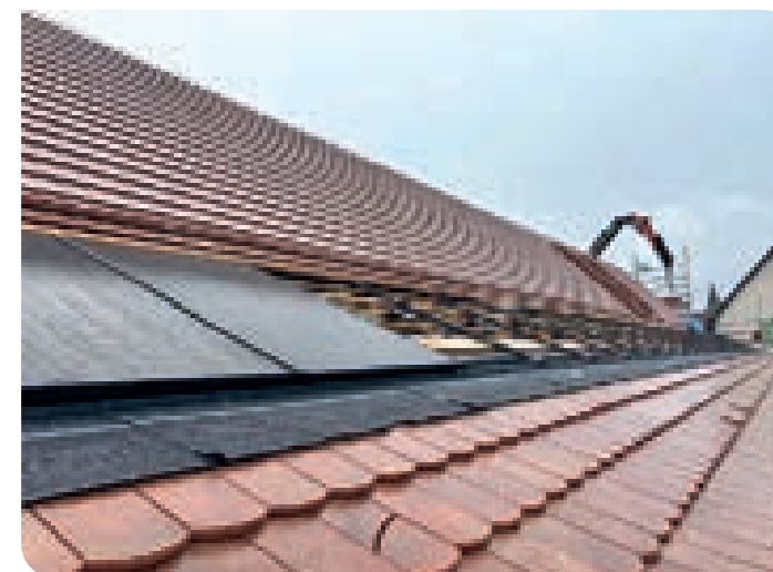
Pose de la couverture et des panneaux photovoltaïques sur le bâtiment Ouest de la résidence
