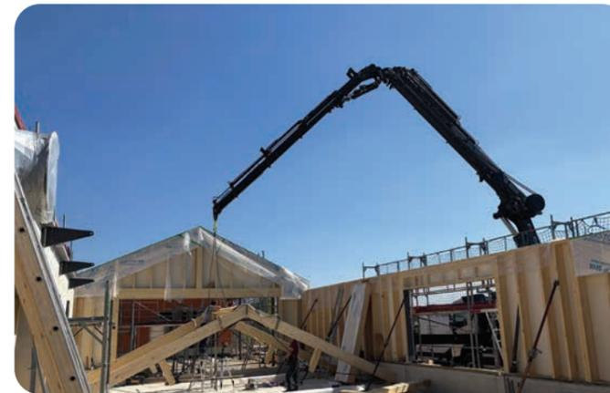
9 avril 2025 : levage des derniers éléments de la charpente au niveau de la future salle de motricité de l'école maternelle.
