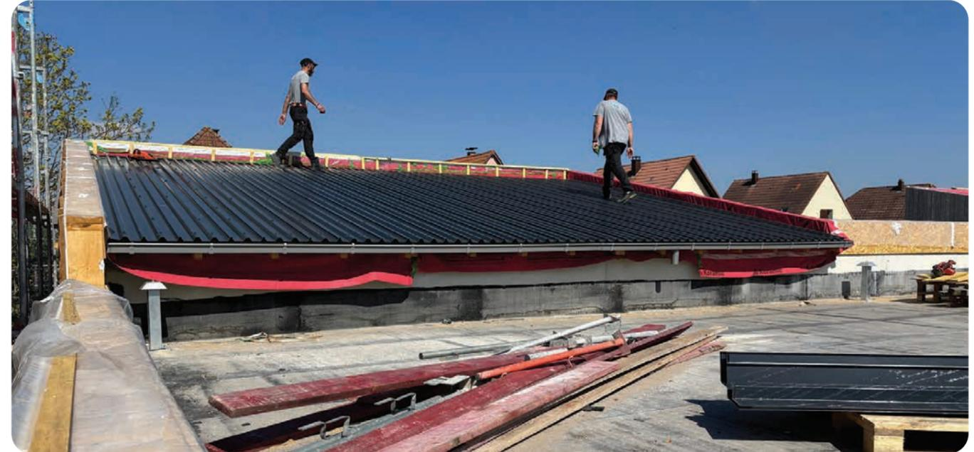
2 avril 2025 : pose des bacs en acier qui vont supporter l'installation de panneaux solaires sur une partie de la toiture exposée plein sud.
