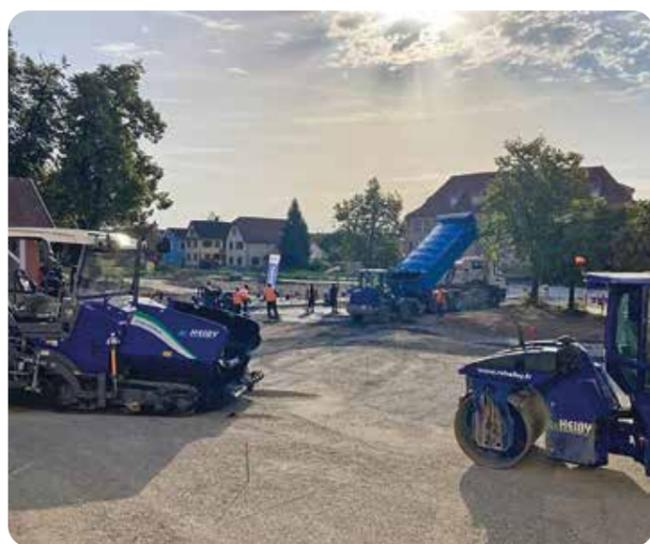
Réalisation de la grave bitumineuse en prévision de la pose du dallage, le 24 août
