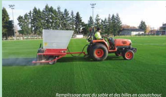
Remplissage avec du sable et des billes en caoutchouc
