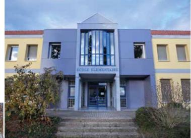
La partie carrelée de la façade n'était plus étanche, entraînant des infiltrations récurrentes. Elle a ainsi été remplacée par un bardage en panneaux composites.
