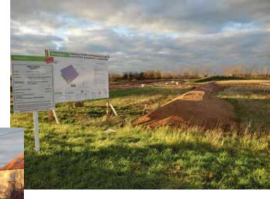
A noter la mise en place par l'Eurométropole de deux bassins de rétention sous forme de noues d'infiltration naturelles pour compenser les surfaces urbanisées et prendre en compte les crues centennales de la Bruche.
